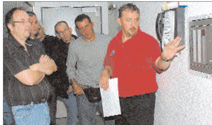
AUFMERKSAM Oblt Michael Dietschi erklärt die richtige Bedienung der Brandmeldeanlage im Bienkensaal.
